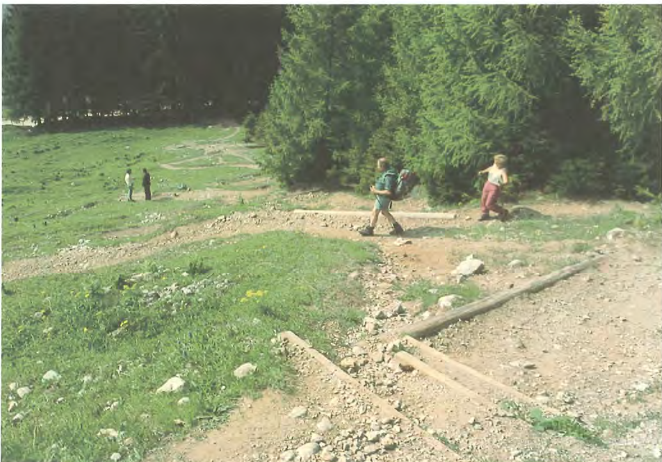
Abb. 7: Wegschäden auf dem steilen, serpentinartig geführten Weg zur Vogelhüttenalm am Jenner. Infolge der Angewohnheit zahlreicher Wanderer die Kehren vor allem im Abstieg oftmals abzukürzen, entstehen Wegabschneider.
