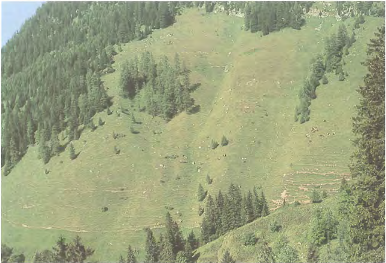
Abb. 25: Narbenversatzschäden entlang von Viehgangeln auf der Krautkaseralm am Jenner.
